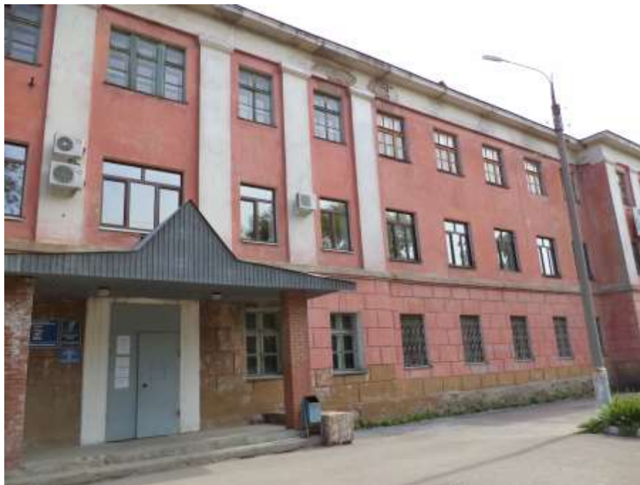
Объект 3: нежилое здание, площадью 4730,20 м 2 , расположенное по адресу: Самарская область, г. Новокуйбышевск, ул. Миронова, д.11 (площадь земельного участка 6957 м 2 ).
